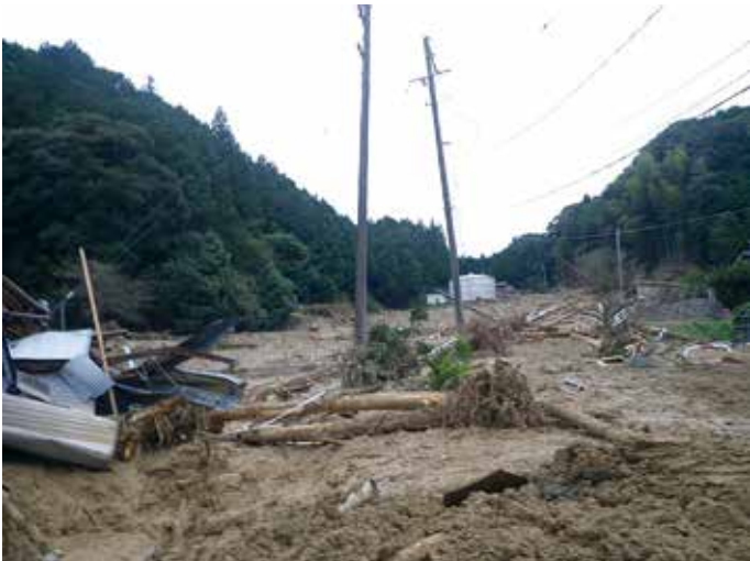
山腹崩落による農地への土砂流入(多気町長谷)
