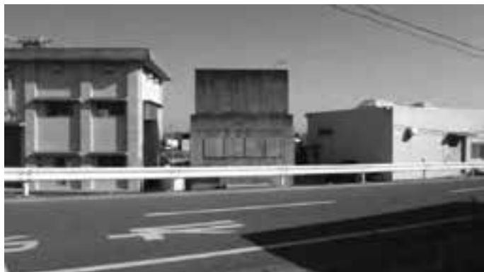
源緑排水機場（右端が新しい排水機場）
