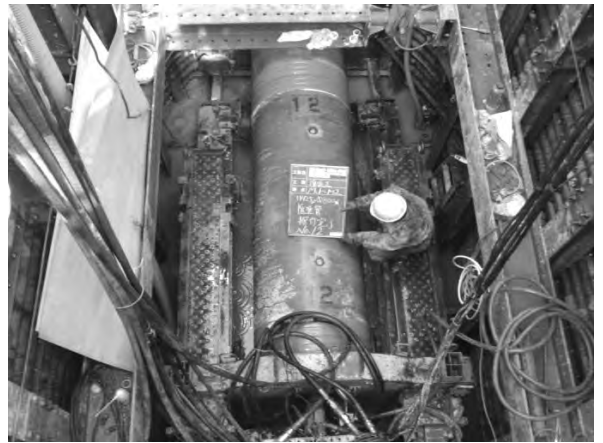
推進管掘進状況 (fig.8)
