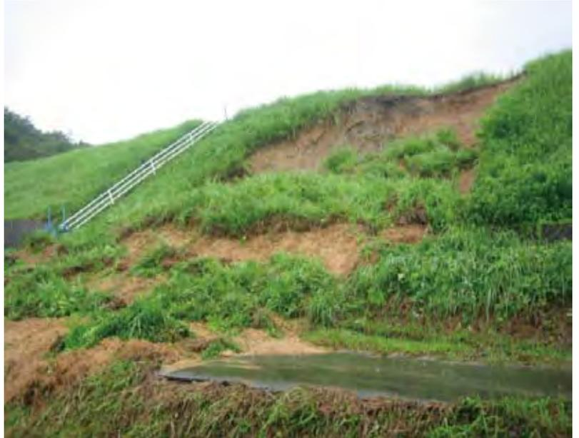
ため池堤体法面の崩落(松阪市 伊勢寺町)
