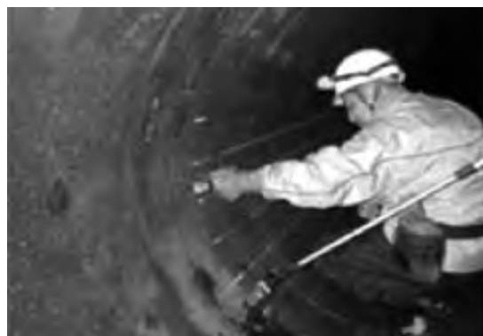
写真-2 PC管電磁波調査状況
