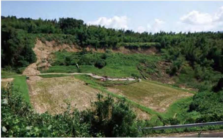
農地の崩落 (伊賀市 東湯舟)
