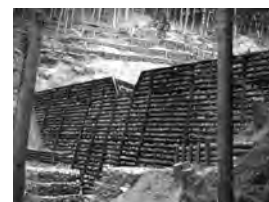
鋼製枠堰堤と木柵工(奥)完成
