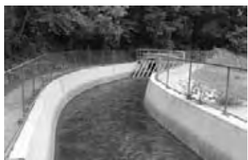
導水路 通水状況
