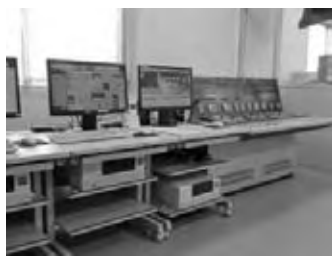
粟生頭首工 操作管理施設
