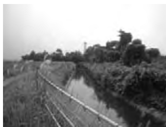
1号幹線水路 施工前
