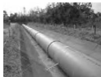
1号幹線水路 施工中
