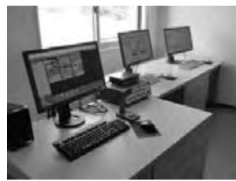
斎宮調整池 操作管理施設
