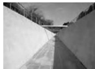
導水路 施工後
