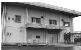
浜市排水機場①
