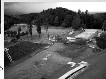
白山ヴィレッジゴルフ場下を通る広域農道(施工中の函渠工)
