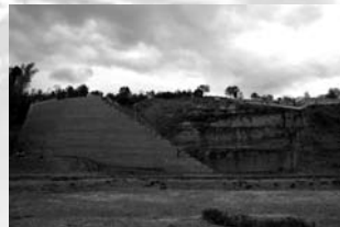
併走する小野谷川とのルートは補強土壁工法を採用
