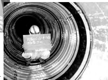
補強リング施工
