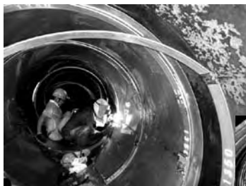
SUS鋼板設置
