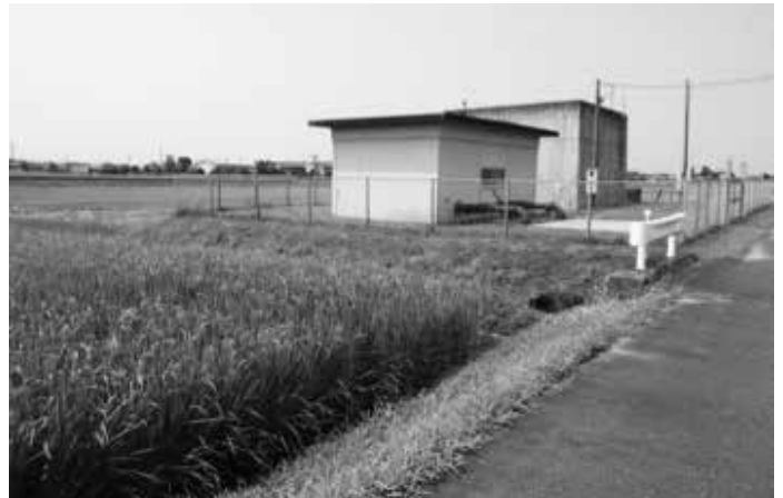
早馬瀬・目田揚水機場
