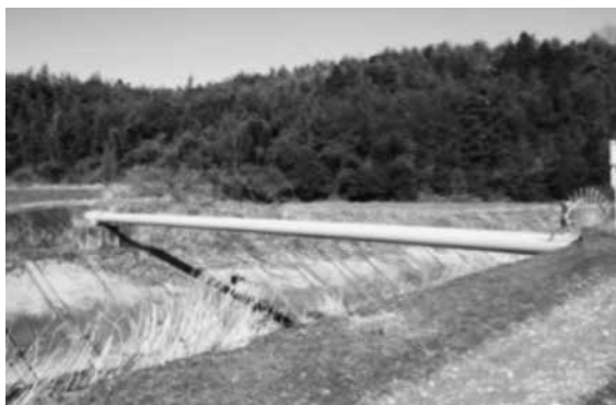
支線用水路水管橋
