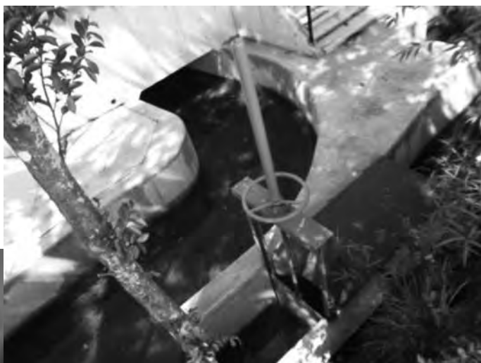
神田二期地区で改修された水路
