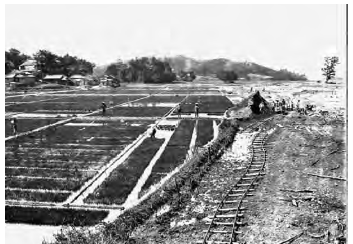
耕地整理工事中の現場
