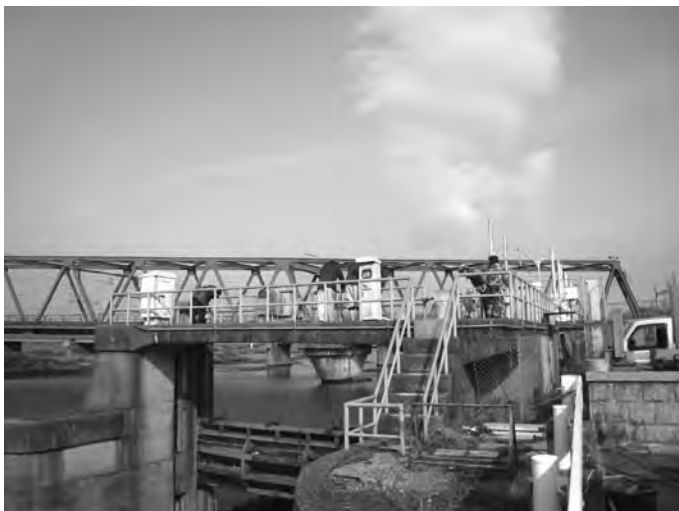
町屋川頭首工
