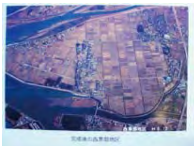
完成後の西黒部地区
