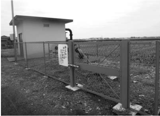
日常維持管理しているC揚水機場
