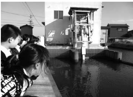
日常維持管理している村松排水機場と見学児童
