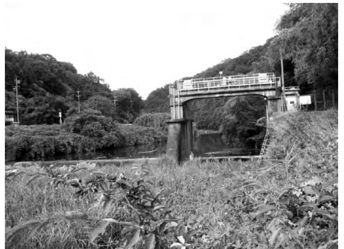
取水の要、上野頭首工
