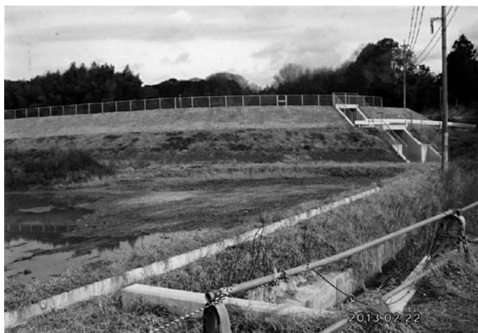
取水源である東奥の谷池
