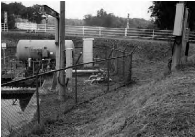
水源地ポンプ場
