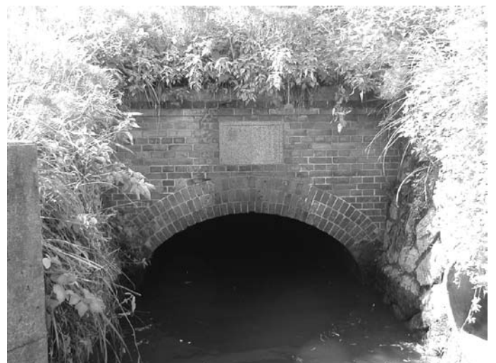
取水口(アーチ型レンガ造り)
