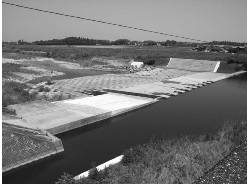
三郷井堰の全景(復旧後)
