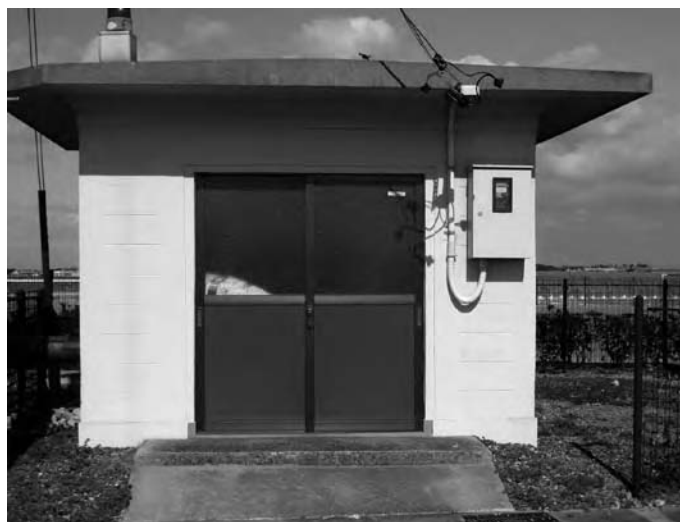
日常維持管理している植山揚水機
