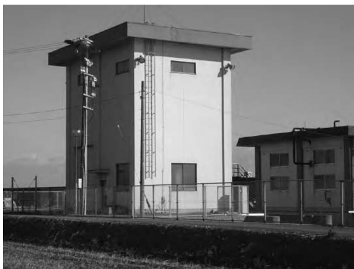
日常維持管理している有滝第2排水機場
