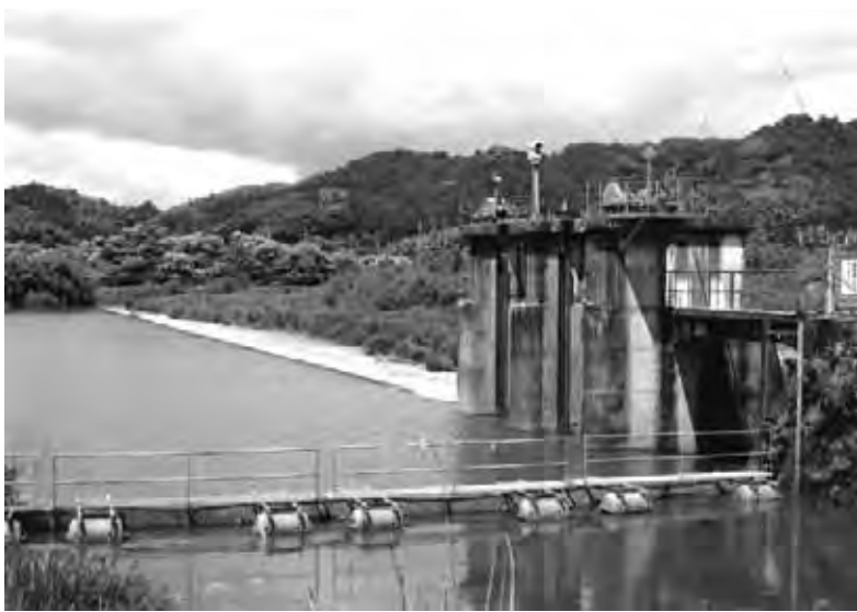
高野井(雲出川)頭首工 固定堰
