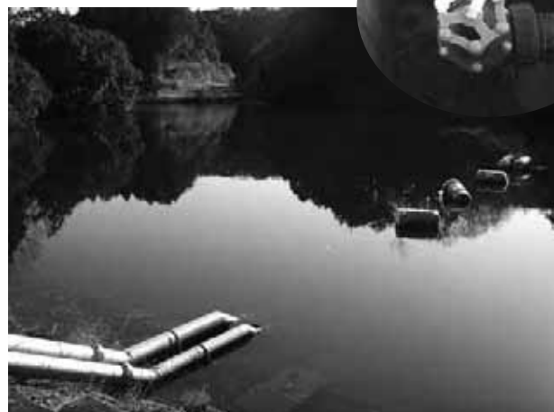
取水源(ため池)と自動給水栓(右上)
