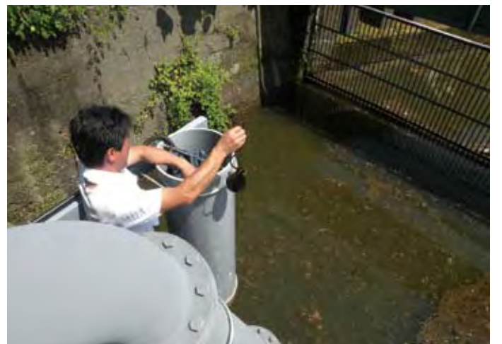
施設の定期診断(東汰上揚水機場 吸込水槽 水位計の確認)
