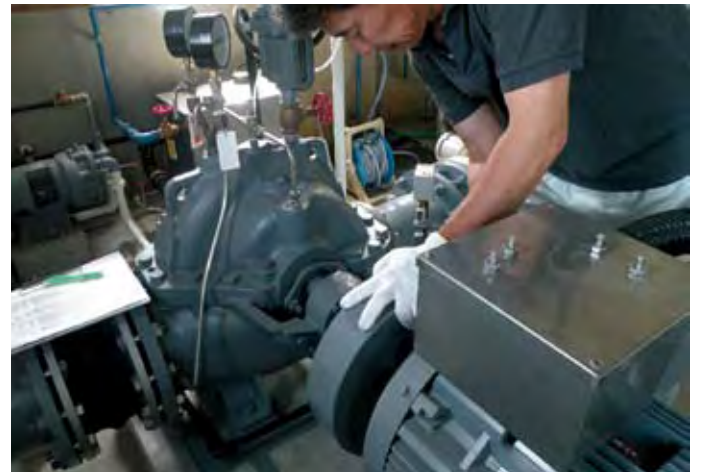
施設の定期診断(東汰上揚水機場 主ポンプ手廻し確認)
