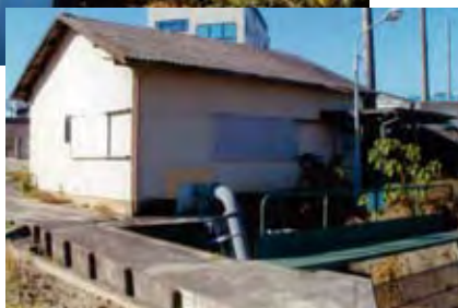
東汰上揚水機場
