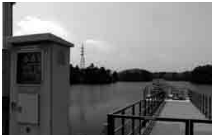
除塵機制御盤
