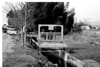
新農業水利システム保全対策事業除塵機設置 (H21年度)
