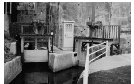
新農業水利システム保全対策事業分水ゲート電動化 (H20年度)
