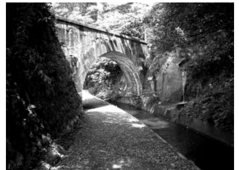
コンクリート製の斜橋 (上部は三岐鉄道北勢線の軌道)
