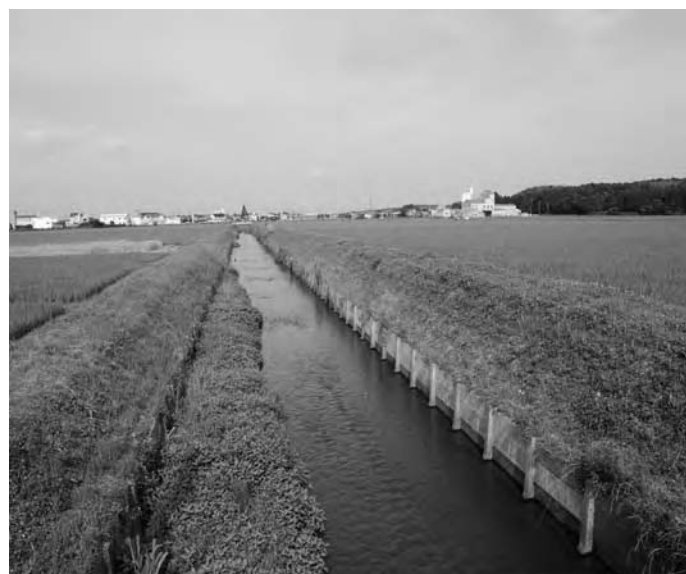
生態系に配慮した斎宮地区幹線排水路とほ場
