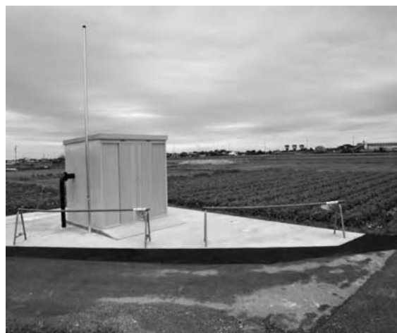
新農業水利システム保全対策事業(下御糸工区)
